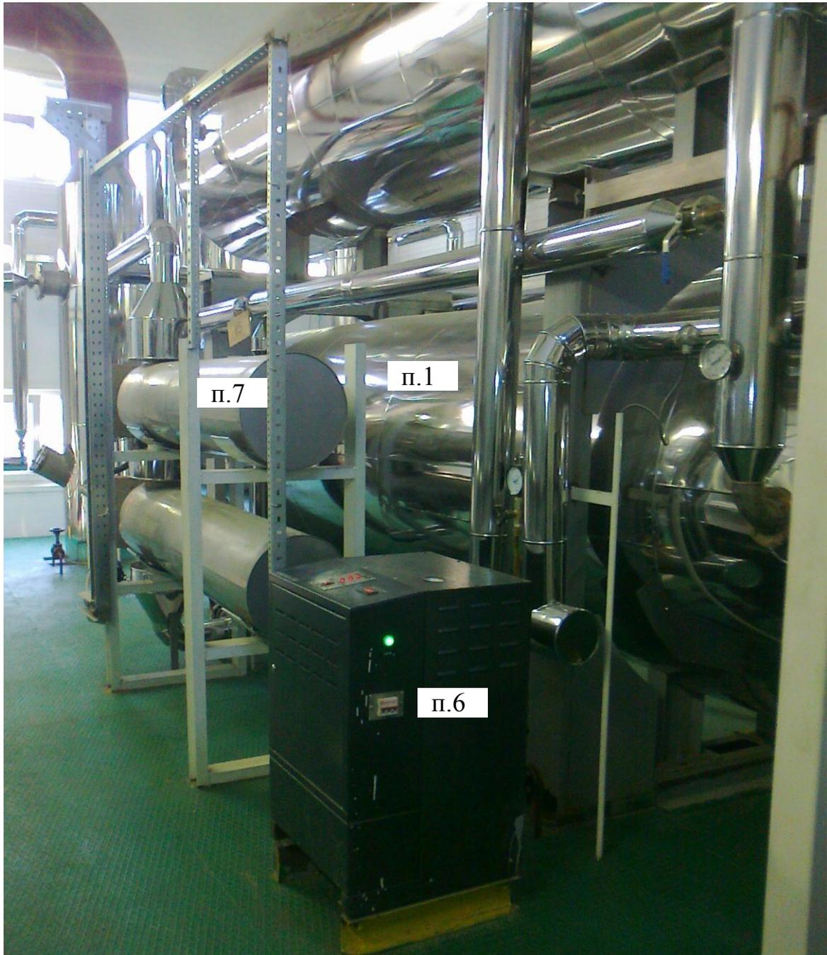
Электрический пароперегреватель поз. 6 предназначен для перегрева водяного пара до температуры 230-250 °С.
